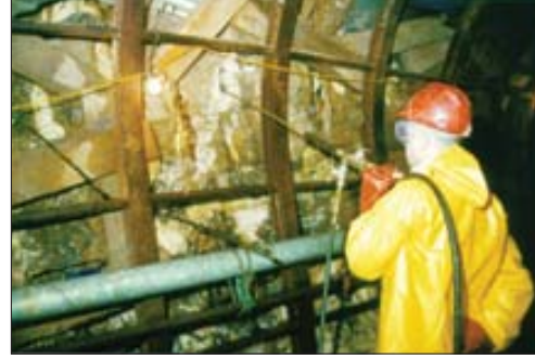
Tünelde Poliüretan uygulaması
